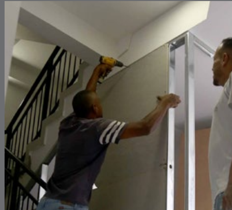
8 mm Plafones exteriores, muros interiores y muros húmedos.
